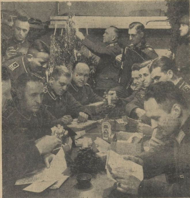
Weihnachten im Bunker einer Küstenbefestigung
