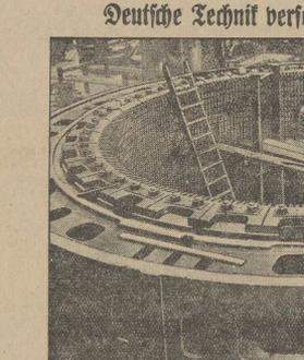
Deutscher Dreifachgenerator für das Schannometer (Arland). Unter Bild zeigt das Einlegen der Welle in den Sektor des Dreifach-Schalt-Generators, den die Siemens-Schuckert-Werke für das Schannometer erbauten. Das Schannometer in Irland ist eines der impoantesten Kraftwerke Europas.
