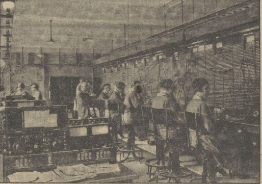
Bild in den Leitungs-Räumen des neuen Berliner Fernsprechamts.
