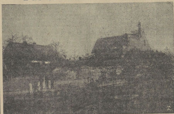
In der letzten Gemeinderatsversammlung in Runstedt wurde beschlossen, das Sekretariatsgebäude, das unter Bild zeigt, abzubauen...
