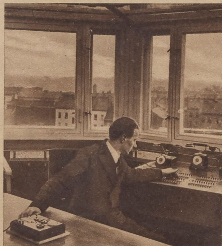
Die erste Lichtwarte wurde in Berlin geschaffen mit dem Zweck, die Beleuchtung der Weltstadt den jeweiligen Lichtverhältnissen anzupassen. Die in 50 Meter Höhe errichtete und mit feinen Meßapparaten ausgestattete Station arbeitet in den Stunden um Sonnenuntergang und aufgang und sorgt für genügende, aber nicht übertriebene Straßenbeleuchtung Atlant
