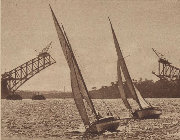
Die mächtige Eisenbrücke über den Hafen von Sidney wächst allmählich empor. Sie wird nach Fertigstellung die größte und infolge der hohen Arbeitslöhne in Australien voraussichtlich auch die teuerste Stahlbrücke der Welt sein. — Abend und feierliche Ruhe in dem Sidneyer Hafen
