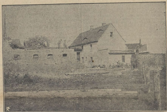
Bei den Abbrucharbeiten.
