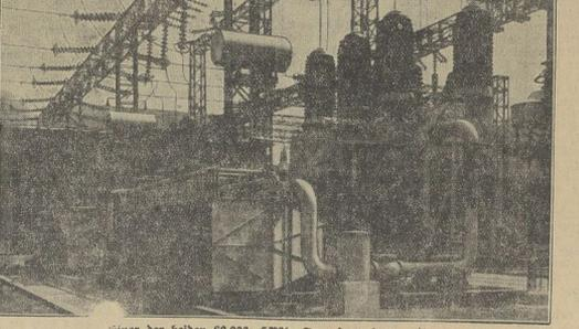
Ziner der beiden 60.000-kV-Transformatorn mit Höchstspannung in Umspannungsbereich (Vorarlberg) für die 220.000-Volt-Leitung.
