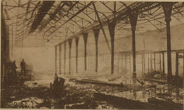
Bild links: Sieben Güterzüge verbrennen. Durch Explosion in einem beladenen Wagen entfiand in einem Schuppen des Güterbahnhofes Hannover ein Heizenbrand, der die Halle und die sieben dort eingefahren Güterzüge einscherte. Nur die Stengehälle der Halle und der Wagen (rechts im Bild) blieben übrig. Presse-Photo
