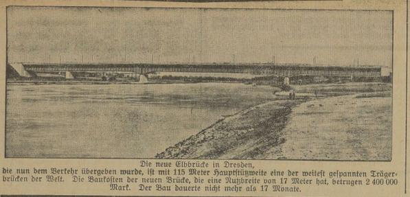
Die neue Hofstraße in Dresden, die nun dem Verkehr übergeben wurde, ist mit 115 Meter Hauptpflanzlinie eine der weitest gespannten Trägerbrücken der Welt. Die Baukosten der neuen Brücke, die eine Ausdehnung von 17 Meter hat, betragen 2.400.000 Mark. Der Bau dauerte nicht mehr als 17 Monate.
