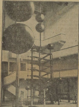
Blick: Gleichstrom-Stationsanlage für 2.200.000 Volt. Links: Ankeranker-Motortreibe für Wechselstrom.
