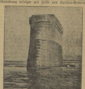
Einer der fertigen Strompfeiler für die Raasdorf-Brücke.
