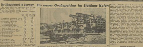
Der neue Stottiner Schuppenspeicher en für Stückgut mißt die kolossale Länge von 210 Meter. Das sechstöckige Gebäude ist ganz aus Eisenbeton unter Vorwendung der "Flüdeckenkonstruktion" ausgeführt, die die Obersichtlichkeit der Raume erhöht und hohe Belastung erfrägt. Das überaus feste Baumaterial ermöglicht es, weitausladende Kräne auf dem Dache selbet laufen zu lassen.
