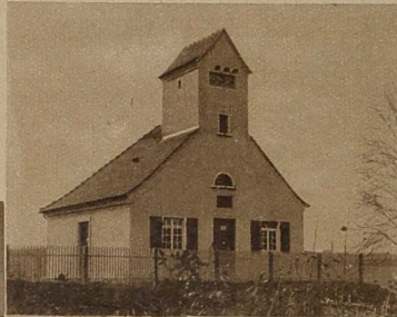
Rechts und unten: Die neueröffnete Donauwasser-versorgung. Geschaffen von einer Gruppe von Gemeinden aus den Bezirken Ehingen, Nieslingen und Biberach. Die Hochbauten fügen sich schön ins Landschaftsbild des württembergischen Oberlandes
