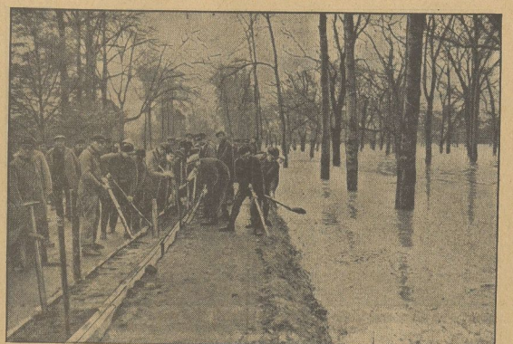
Witterliche der Seemännin Rosalie suchen in Bernburg mit freiwilligen Helfern dem Vordringen des Hochwassers in Bernburg durch Errichtung provisorischer Schutzmauern Einhalt zu tun.
