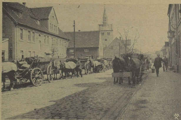
Obereröblingen am See ist ein Zentrum der Braunkohlenindustrie. Wenn die großen Güter der Umgegend Kohlen fahren, stehen oft Dutzende von Geschirren vor den Gasthöfen in der Bahnhofstraße.
