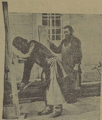
Pfosten für eine neue Kapelle. Mönche arbeiten als Zimmerleute.
