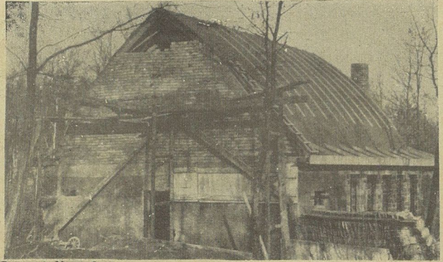
Kapellenbau in Merseburg.
