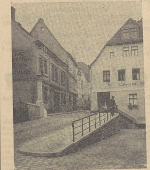
Die Stigube nach dem Umbau.
