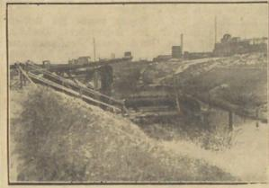
Die Klärflotteleitung mußte sofort abgestellt werden, da der Graben sich natürlich aufblaute. Im jedoch den Klärbetrieb aufrecht zu erhalten, wurden an der Unfallstelle sofort zwei starke elektrische Pumpen eingebaut, die das Wasser von oberhalb der Bruchstelle über die abgeriegelten Erdmassen hin-
