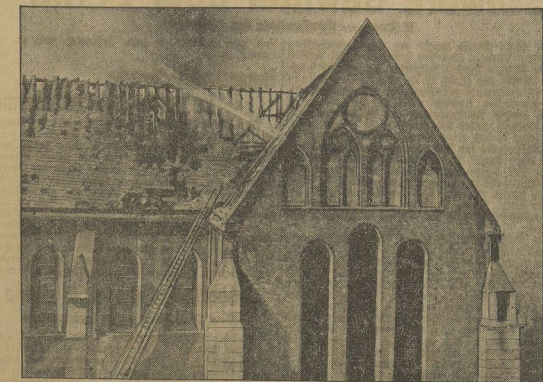
Der gestrige Dachstuhl der Bremer Stephankirche, die durch ein Großfeuer schwer beschädigt wurde.
