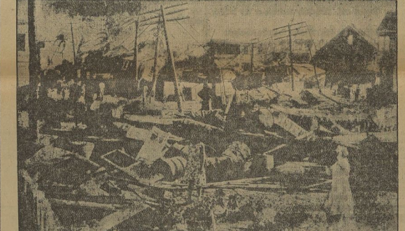
Verhältnissen in der Stadt Zeitz (Deutsch-Souduras), die vor kurzem von einem furchtbaren Wirbelsturm, verbunden mit einer heftigen Springflut, schwer betroffen worden war. Die Katastrophensituation ist hier mehr als 100 Häuser zerstört.
