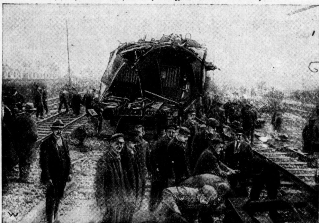
Aufräumungsarbeiten an der Unglücksstätte.
