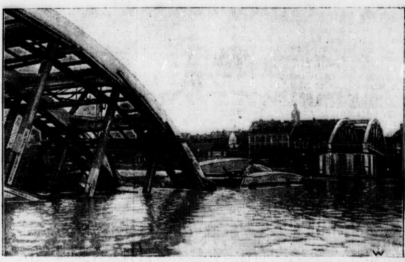
Im Vordergrund der durch den Wegbruch des Pfeilers gelöste erste Wühlbogen, Mittelbogen und Pfeiler sind im Strome verfunken. Im Hintergrunde die Stadt Garz.
