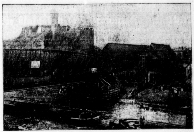
Der Stand der Arbeiten an der Cröllwitzer Brücke
