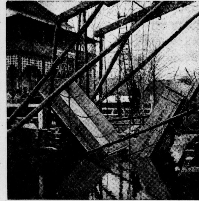
Ein Kaltstau bricht durch eine Brücke. Die bei Wendisch-Bleibitz (in der Mark) über den Storow-Kanal führende Zugbrücke brach unter einem Kaltstau zusammen. Während der Zugwagen noch glücklich über die Brücke kam, stürzten die beiden mit Schotter beladenen Anhänger ins Wasser und besetzten den Mitfahrer unter sich, der ums Leben kam.
