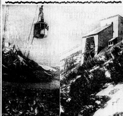
Die neue Seilseilbahn bei Garmisch-Partenkirchen, die bei einer Seillänge von 2800 Metern einen Höhenunterschied von 1100 Metern überwindet, wurde gestern fertiggestellt. — Links: Blick auf Partenkirchen. — Rechts: Die Station am Wank in 1780 Meter Höhe.
