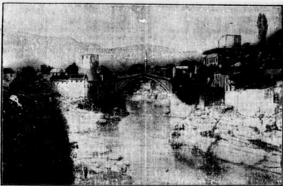
Das schöne Mostar am Karawatsch-Fluß In großen Teilen Jugoslawiens, vor allem in der Herzegovina und Dalmatien, hat sich ein schweres Erdbeben ereignet. Der Ort lag auf der Linie Juliane in der Herzegovina bei Skajuga. Besonders stark war das Beben in Mostar, wo schwere Verwüstungen eintraten und bei dem es viele Tote und Schwerverletzte gab.
