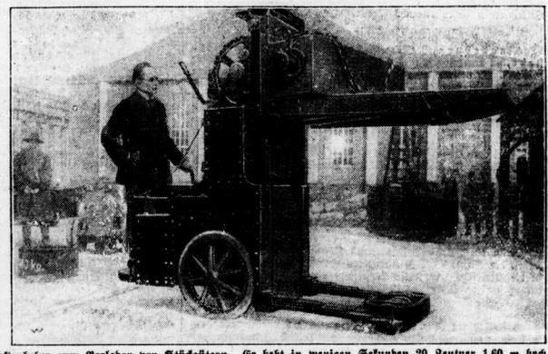
Lastenheber zum Verladen von Stückgütern. Er hebt in wenigen Sekunden 20 Zentner 1,60 m hoch.
