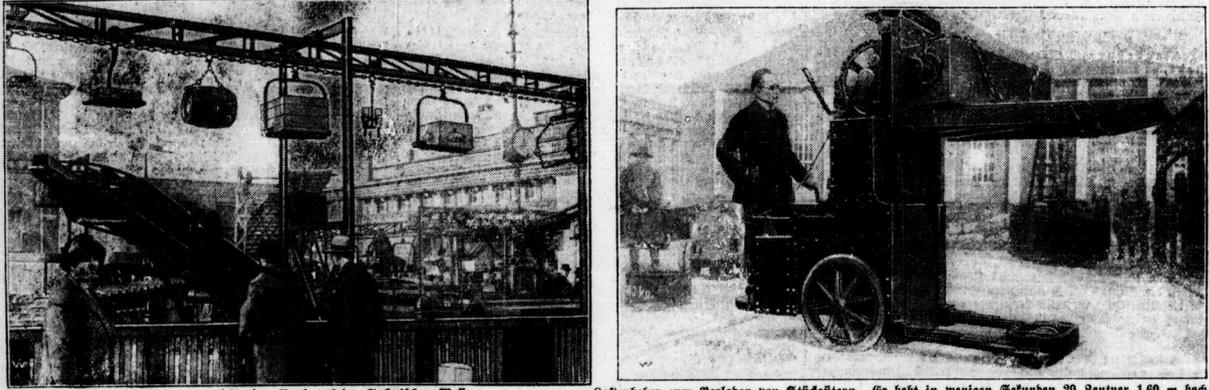
Lastenheber zum Verladen von Stückgütern. Er hebt in wenigen Sekunden 20 Zentner 1,60 m hoch.
