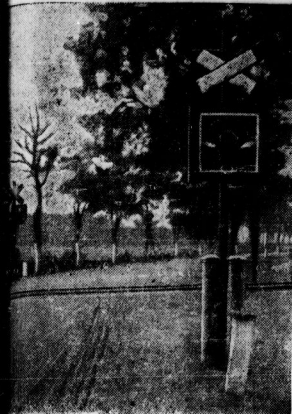
Eine neue Sicherung der Bahnübergänge Es geht jetzt von der Reichsbahn verfahrensweise ein. Der freie Übergang wird durch ein Gitterwerk angezeigt, das 45mal in der Sekunde aufsteigt. Die Annäherung eines Zuges wird automatisch ein rotes Licht ein, das 80mal in der Minute blinkt.
