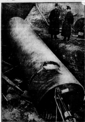
Der Unfallort, dessen Verschluss durch die Explosion abgerissen wurde.
