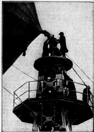
Das „Meißelgeschicht“ ermöglicht es, daß ein mit der Spitze des Aufschiffes verbundener Reil in einem am Aufschiff befindlichen Trichter verfenkt und dort verriegelt wird.
