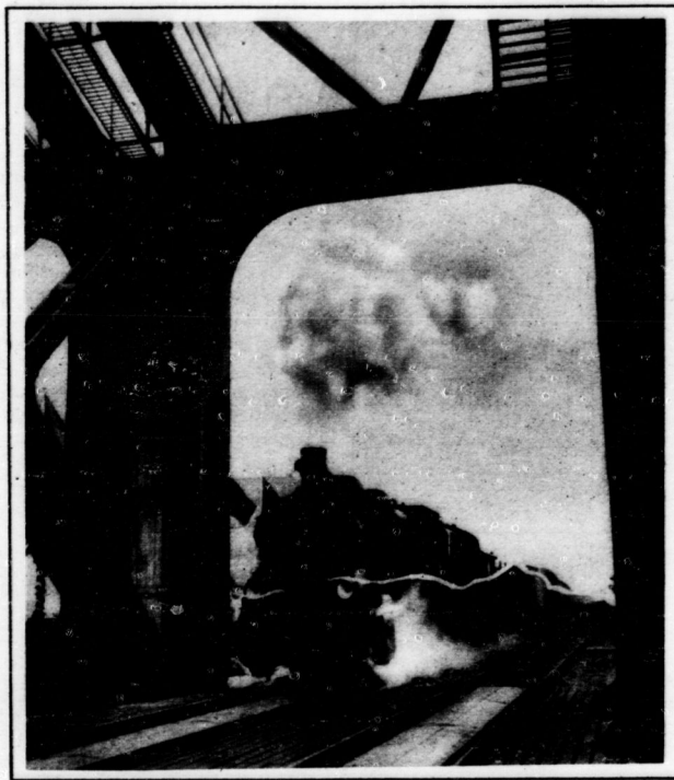
Von der feierlichen Eröffnung der neuen Norderebebrücke bei Hamburg Die neue Brücke, ein Meisterstück deutscher Brückenbaukunst, ist 300 m lang und hat ein Gewicht von 5400 Tonnen. — Der erste Zug passiert die Brücke und durchschneidet das Einweihungsband. Phot. Sennecke
