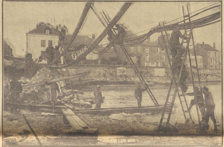
Eine Feldtelegraphen-Abteilung beim Legen von Kabeln.
