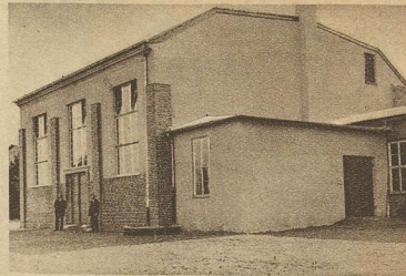
Die neuerbaute Turnhalle (Teilansicht) des Turnvereins Turnerbund in Altenburg (Thür.)
