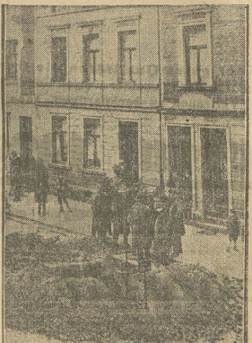
Die Untersuchungskommission an der Unfallstelle. Am Donnerstag wurden der Feiler Brüggenmann und zwei fei-
