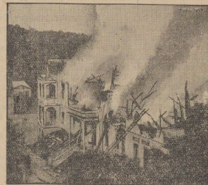
Das Gebäude während des Großbrandes.
