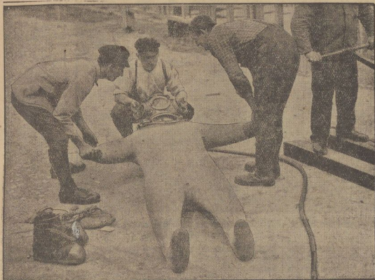
So wird der Anzug eines Tauchers auf seine Undurchlässigkeit geprüft.
