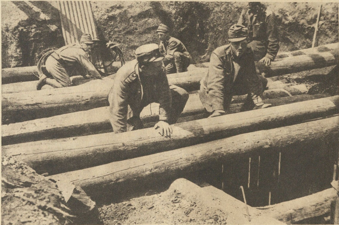
Beim Bau der Unterstände.
