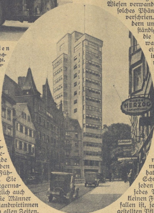
Turmbau des Stuttgarter Neuen Tagblatts [Phot. Eporeer]
