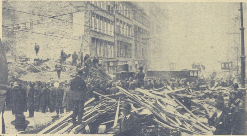
Eines der größten Bauunglücke: Ein 8stöckiger Neubau in Prag stürzte unter fürchterlichem Getöse zusammen und begrub unter sich über 80 Arbeiter, viele Passanten und 2 Pferde.
