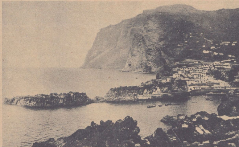
Furchtbare Erdbeben-Katastrophe in Madeira. Über hundert Tote Bild auf das Städtchen St. Vincente mit der vom Erdbeben betroffenen Küste.
