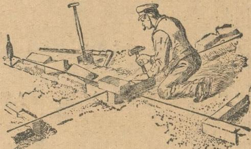
Abbildung 3. Das Eck von Mauersteinen nach der Schnur.
