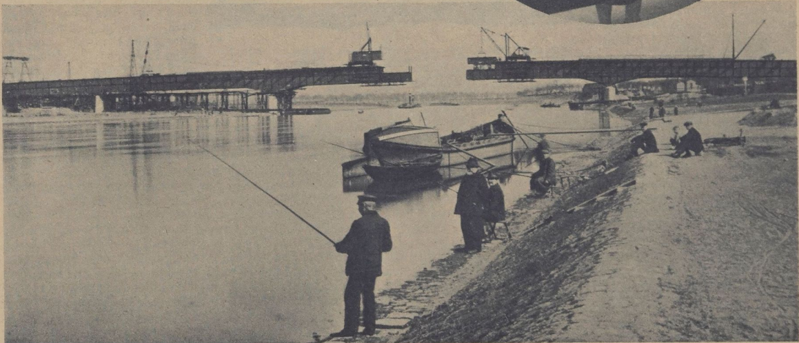
Die neue Elbbrücke in Dresden kurz vor Zusammenfluß des mittleren Bräudenbogens mit einer Stützweite von 115 m. [Atlantia]
