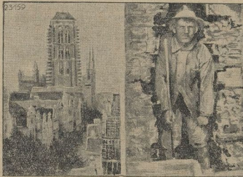
Einsturzgefahr für die Marienkirche in Danzig. In der mittleren Höhe des Turms der altberühmten St. Marien-Kirche in Danzig sind Risse entstanden, die an der Wand- und Stützeleiste breiten, daß sie einem Mann kaum bieten. Der berühmte Bau, der in seinem Innern kostbare Kunstgegenstände birgt, muß als gefährdet gelten, wenn nicht die Restaurierung mit größeren Mitteln als den vorhandenen vorgenommen wird. Unter Bild zeigt die gefährdete St. Marien-Kirche in Danzig und rechts einen der Klaffen Risse in der mittleren Höhe des Turmes.
