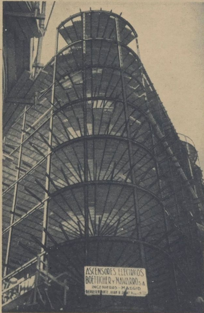
Geschäftshochhaus im Bau
