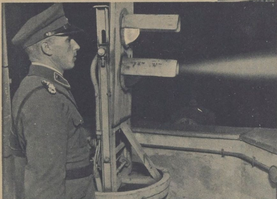
Starterlaubnis bei Nacht wird dem diensttuenden Personal durch Lichtsignale gegeben.
