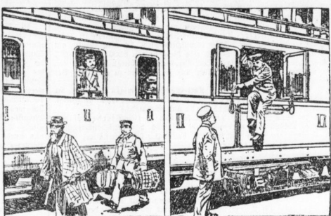
Die Fenster bei den alten und bei den umgebauten Wagen.
