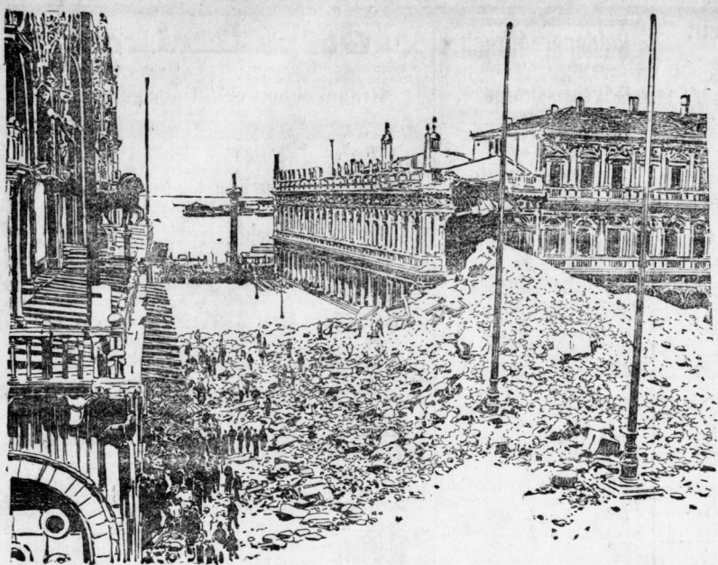
Trümmer des Campanile von San Marco.
