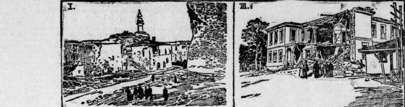
Granzulwirkung an einem Nebengebäude innerhalb der Festung Kaleh Sultanzieh.
