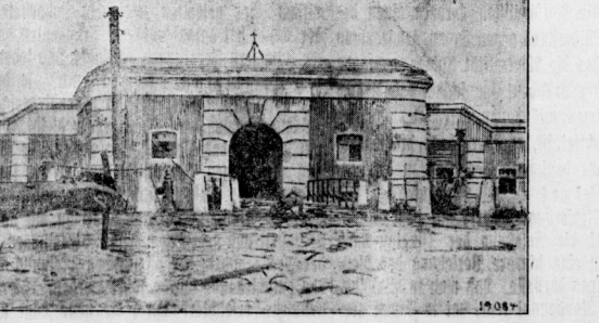
Die Belagerung von Antwerpen: Das beschlossene Fort Gebrants, davon ein Geschütz, das durch den gewaltigen Druck über den Fluß hinweg auf den Weg getrieben wurde.
