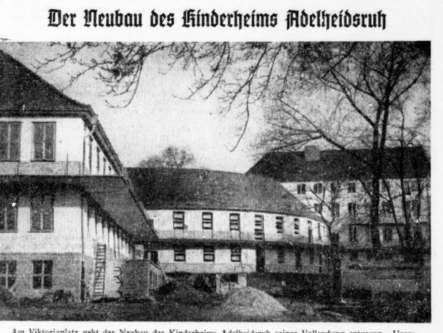
Am Viktoriaplatz geht der Neubau des Kinderheims Adeltshausruh seiner Vervollendung entgegen...
