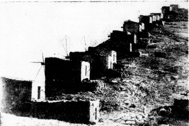
Eine Merkwürdigkeit auf Kreta ist der Windmühlenspaß in Lassithi-gebirge. Hier fangen sich die mit seltener Gleichmäßigkeit wehenden Nordwinde so stark, daß 40 Windmühlen nebeneinander aufgestellt wurden. Eine Drehvorrichtung haben diese Windmühlen nicht, da der Wind im Sommer fast nur aus einer Richtung kommt.
